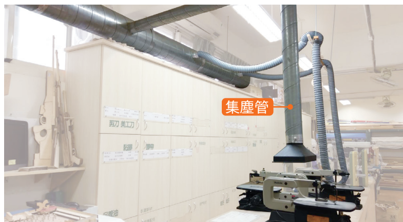
▲ 圖2-1-25 除塵設備。線鋸機上方設有集塵管，可吸收鋸切時產生的粉塵。
