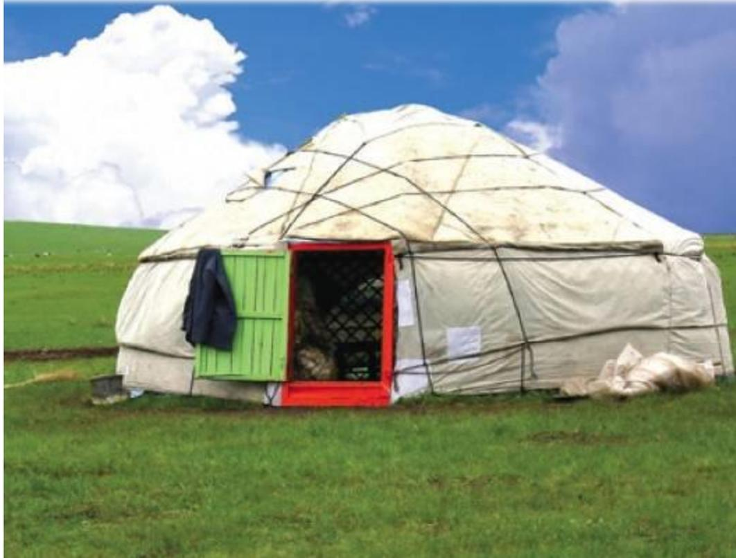
圓弧外形的蒙古包可減寒風威力，傘狀頂部可排除雨雪，加上易於拆建的特點，為蒙古族的傳統住所。
