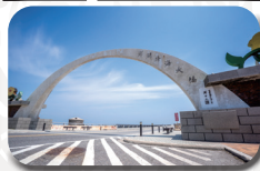
澎湖 跨海大橋
