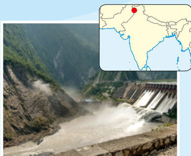
▲照片4-1 薩拉大壩 印度於印度河上游興建薩拉大壩，造成下游巴基斯坦流量減少，導致兩國水資源衝突
