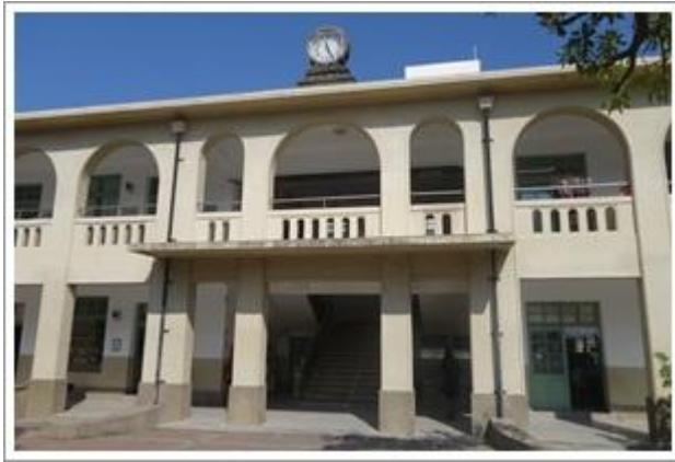
北棟教室南側中間的大雨庇
