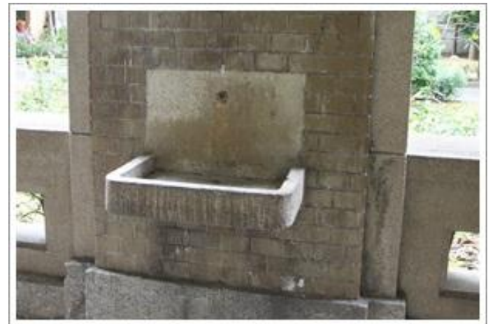
大同國小前棟大樓所留存的舊洗手台
