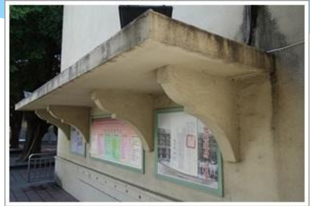
北棟教室西側的大雨庇
