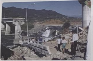
③ 橋樑斷裂 (臺中市大坑橋，民國88年)
