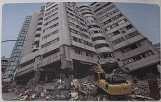
④ 樓房傾斜、倒塌 (花蓮縣雲翠大樓，民國107年)
