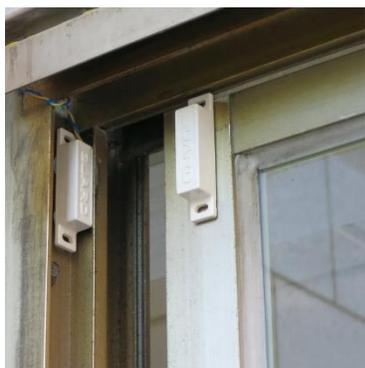
常見於門窗防盜設備。磁簧開關的兩個配件分別安裝於窗框、窗戶上。閉合時兩配件靠近；打開時磁鐵遠離磁簧管，造成電路斷路，則會啟動警報系統。
