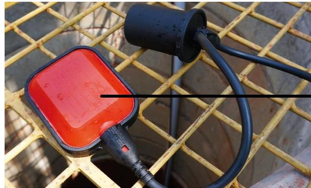
常用於偵測設備傾斜，或利用翻轉控制通、斷電。
