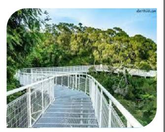
天空步道以輕型鋼架為結構,柵欄式線條造型。 以點、線、面的構局形式,連結南北向的景點, 路線從空中穿越卦山路,由大佛坐落處順著山 勢蜿蜒而建,全長 1005 公尺,高度最高 16 公 尺。不僅有高空視野,更能漫遊森林,體驗樹冠 層生態之美,形同「空中之橋」,是全台最長的 天空步道。
