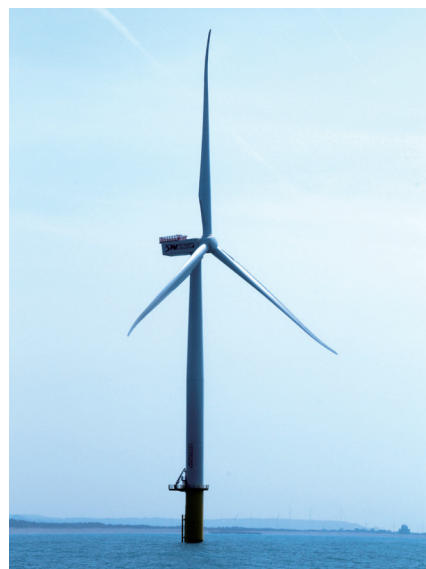
照片 4-7 臺灣首座離岸風力發電機位於苗栗縣竹南鎮，2017 年開始運作，目前最多可供電約 8,000 戶家庭，每年減少的排碳量相當於 40 座大安森林公園的二氧化碳吸收量。
