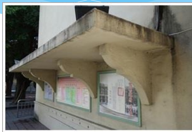
北棟教室西側的大雨庇
