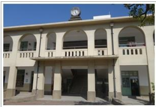
北棟教室南側中間的大雨庇
