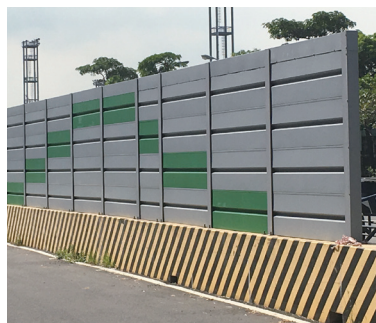
A 道路旁的隔音牆
